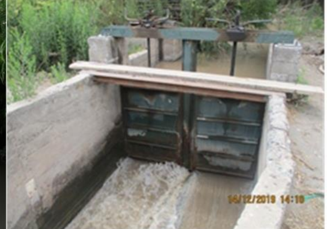
Foto 4. Canal Comunidad Panquehue.
